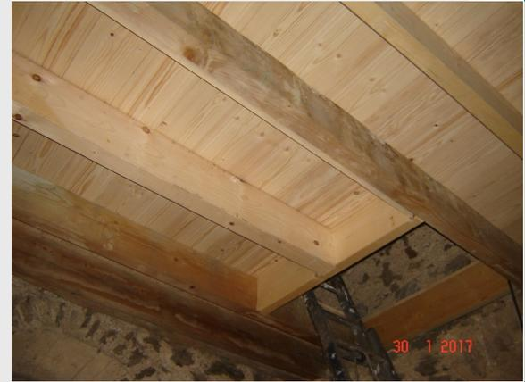
Le plancher vermoulu a été remplacé, de même que les échelles d'accès.
