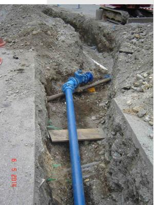
Sur la place du Vivier, une nouvelle conduite d'eau a été posée. Les habitants ont été connectés. La séparation eaux usées / eaux pluviales a également été réalisée dans ce secteur, et le raccordement des grilles "avaloir" des rues au réseau pluvial est fait. Les habitants recevront un courrier pour se raccorder à ces réseaux. L'enrobé sera également bientôt refait.
